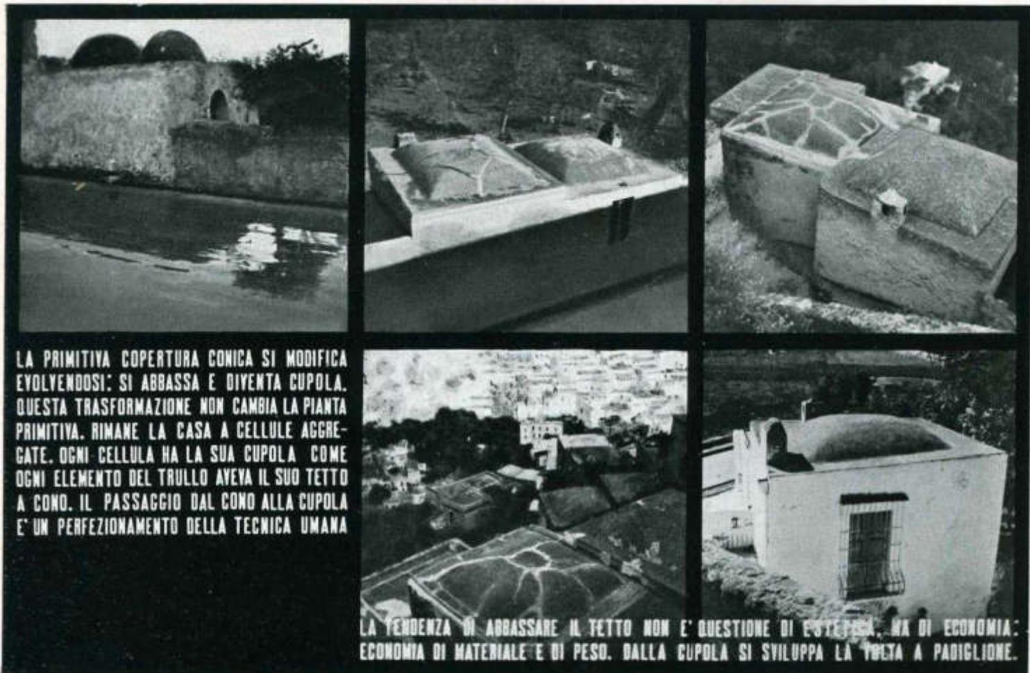
LA PRIMITIVA COPERTURA CONICA SI MODIFICA EVOLVENDOSI: SI ABBASSA E DIVENTA CUPOLA. QUESTA TRASFORMAZIONE NON CAMBIA LA PIANTA PRIMITIVA. RIMANE LA CASA A CELLULE AGGREGATE. OGNI CELLULA HA LA SUA CUPOLA COME OGNI ELEMENTO DEL TRULLO AVEVA IL SUO TETTO A CONO. IL PASSAGGIO DAL CONO ALLA CUPOLA E' UN PERFEZIONAMENTO DELLA TECNICA UMANA
